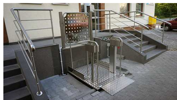
platforma dla niepełnosprawnych zamontowana przy schodach
