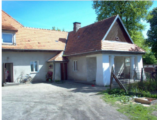
Fot. 5. Oficyna dworska zespołu parkowo-dworskiego w Chelmicy Dużej Źródło: Analiza „twardych” zasobów kulturowych i historycznych, Innova Consulting
