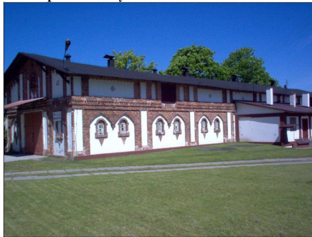
Fot. 8. Dwór i folwark w Szpetalu Górnym
