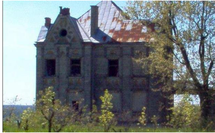
Fot. 7. Dwór w Zarzeczewie Starym
