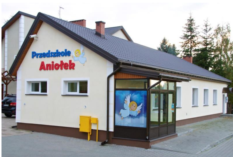
Fotografia 9. Budynek Przedszkola Aniołek w Szpetalu Górnym
