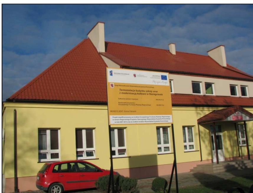
Zdjęcie 3.1 Budynek Zespołu Szkół w Nasiegniewie został poddany w latach 2011-2013 gruntownej termomodernizacji
